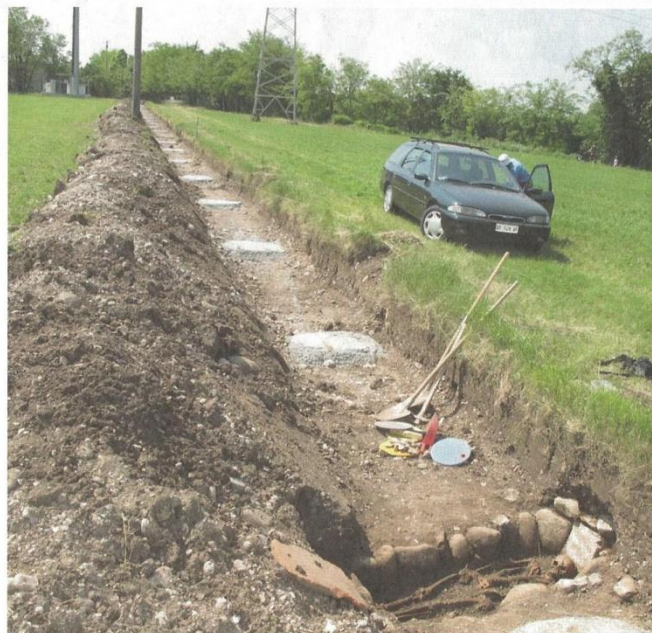
Il fossato per l'irrigazione oggetto dei lavori del Consorzio Mediochiese
